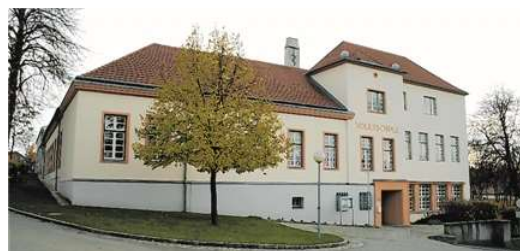
◀ In den Sommerferien 2024 sollen die Sanitäreinrichtungen in der Volksschule saniert werden. Foto: Wikipedia
